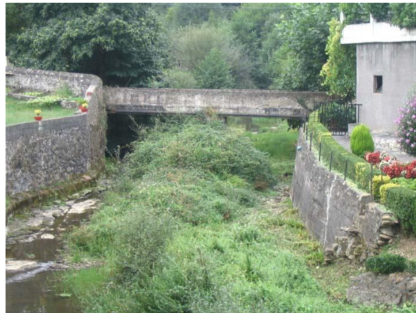
Figura 19: imagen de un puente y encauzamiento en el municipio en La Matanza.
