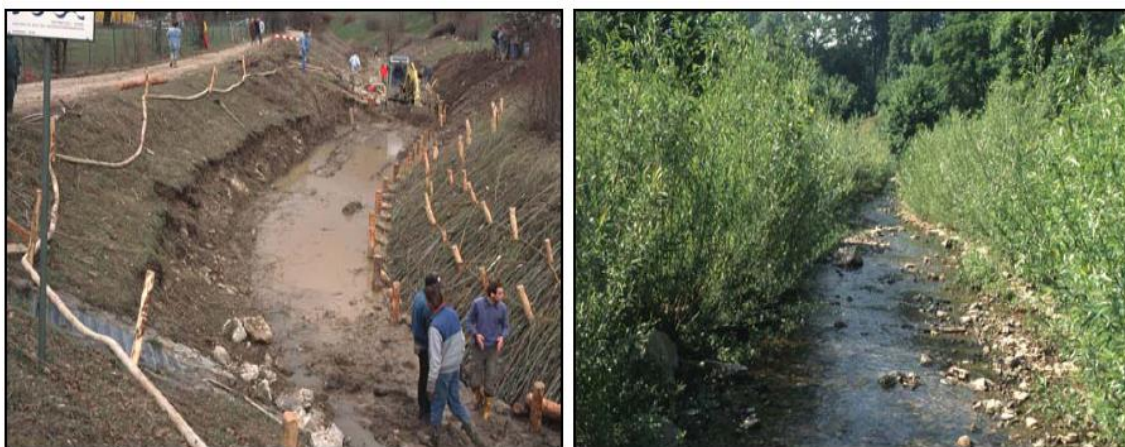
Figura 1: Ejemplo del antes y el después de la estabilización de taludes en un cauce con el uso de vegetación. (Fuente: Estudio Integral para la recuperación hidráulico-ambiental del arroyo Borrico en Limpias)
