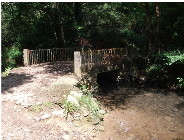
Figura 14: Puente que cruza el Río Oriñón.
