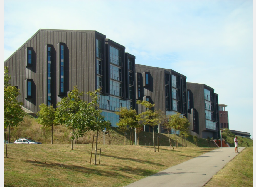
Edificio Usos Polivalentes
