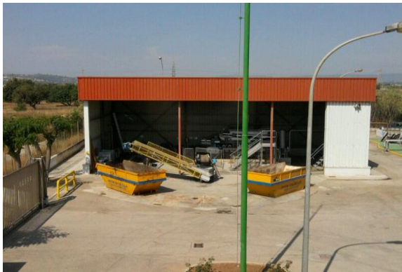
Foto 11. Nave de deshidratación de los fangos
