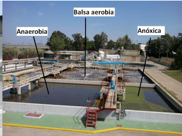
Foto 8. Sistema combinado de eliminación de materia org. y nutrientes.
