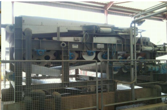
Foto 12. Filtros banda deshidratadores de lodo
