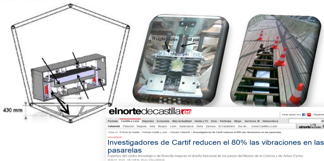
Figura 14: TMD instalado en la pasarela
