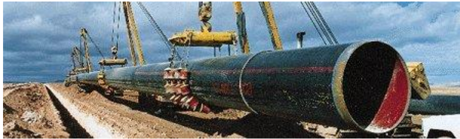
Imagen 3: Construcción de gasoducto
