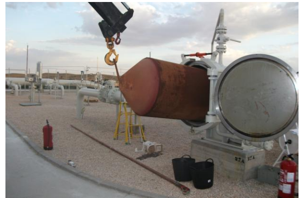
Imagen 8: Extracción del Poli-Pig
