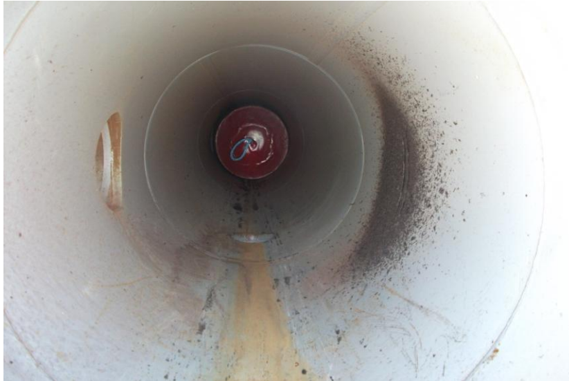
Imagen 4: Poli-pig introducido en la tubería
