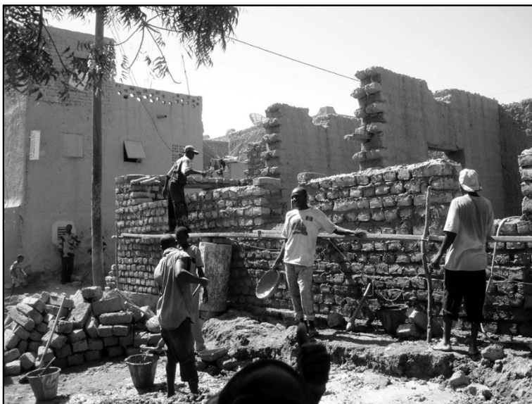
Fig. 3.– Construcción de una escuela en Mopti (Mali) mediante adobes de barro de gran formato.
