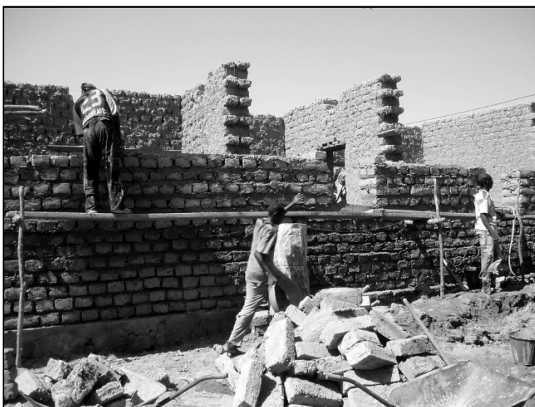
Fig. 4.– El edificio construido mediante esta técnica tradicional adquiere una gran inercia térmica como respuesta al calor extremo de la región. El uso de técnicas tradicionales permite la asimilación del proyecto por parte de la población local, al tiempo que le ayuda a recuperar su autoestima y el orgullo su cultura tradicional.
