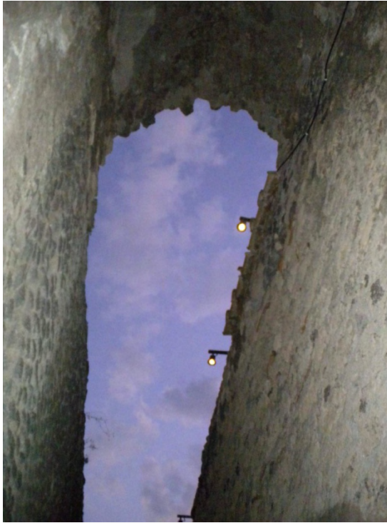
Fig. 4: tramo de bóveda escalonada que cubre la pendiente que da acceso al teatro grande de Pompeya. El sistema de ejecución de las bóvedas es a base de ladrillos colocados sobre sus cantos con la parte más larga vista. Se trata del mismo modo de ejecución visto en las torres de ladrillo.
