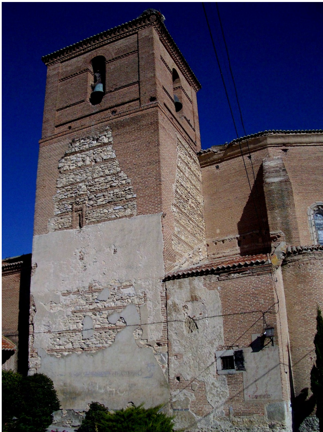
Fig. 4: torre de la iglesia parroquial de Sinlabajos. Flancos sur y este.
