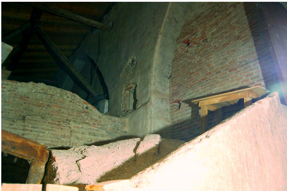
Fig. 12: muro norte del templo primitivo que, aunque enlucido, perforado y tapiado parcialmente, conserva la traza original. Se observa la bóveda de ladrillo dieciochesca que se construye entre los dos muros para conformar una capilla devocional lateral.
