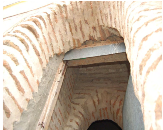
Fig. 23: arcos de la parte exterior e interior de la puerta de acceso a la torre. Entre uno y otro existe un espacio que se cubre con bóveda de cañón y que funcionaba como arranque del primer tramo de escaleras embutidas en el muro. Este tramo comunicaba el nivel de acceso a la torre con un forjado de madera situado a media altura de la primera cámara.
