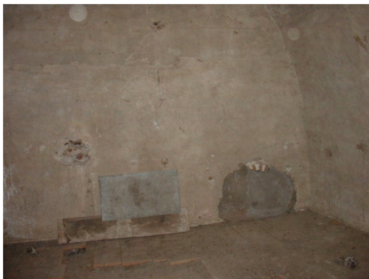
Fig. 19: Prácticamente ocultas mediante una capa de mortero de cemento se encuentran las trazas de la parte superior de la puerta de acceso a la torre. Esta posición nos indica que el forjado actual no está relacionado con los niveles originales de la torre.
