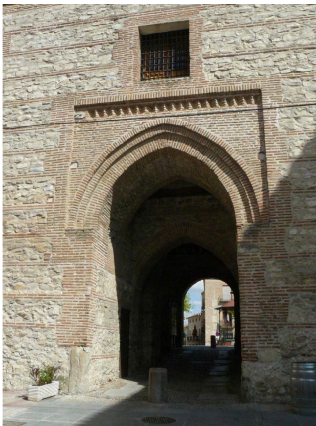
Fig. 19: puerta del Alcocer en la muralla de Arévalo. Repite la secuencia decorativa de San Nicolás de Bari, en Madrigal de las Altas Torres, que a su vez, se relaciona con Horcajo y con Espinosa de los Caballeros.
