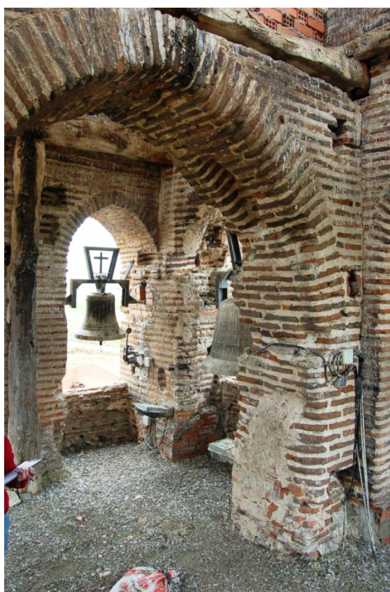
Fig. 46: arco que conecta la cara interior este con la oeste. En la imagen se aprecia en el intradós del arco el cajeadado para empotrar en él la estructura auxiliar de sujeción de las campanas. Se ve en el encuentro con el cierre perimetral del cuerpo de campanas que el arco se adosa con posterioridad aunque los ladrillos que lo componen tienen dimensiones que los aproximan a la manufactura ladrillera medieval.
