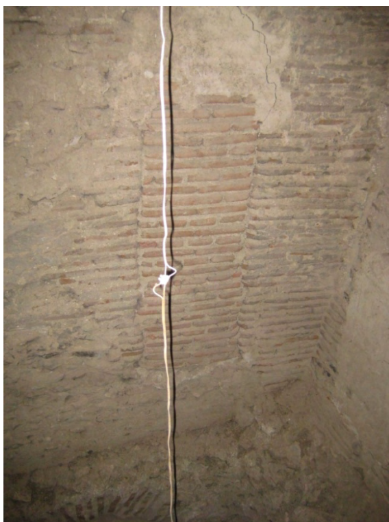
Fig. 13: puerta de acceso a la segunda cámara, situada en el muro sur de la torre. Localización de las trazas en la sección B-B.
