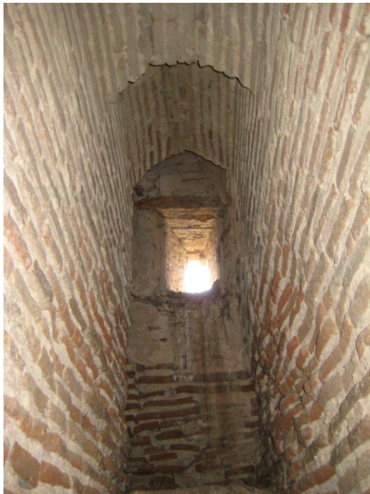
Fig. 18: ventana al final del primer tramo de escaleras, producto con toda seguridad de una reconstrucción al derrumbarse el esquinazo en el que se encuentra.
