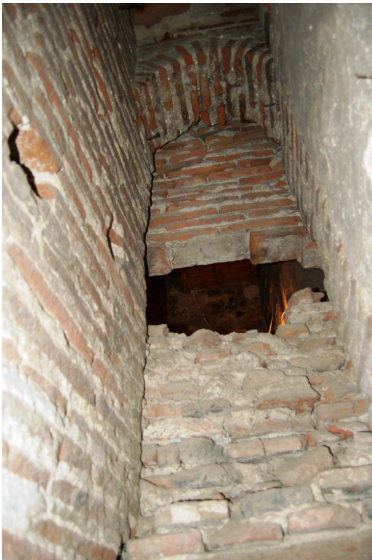
Fig. 30: puerta parcialmente tapiada que daba acceso al interior de la primera cámara. Este arco permite localizar con total precisión la entrada original.
