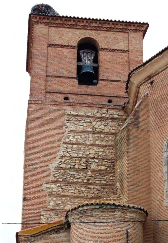
Fig. 16: fachada este de la torre de Sinlabajos en la que se aprecia el relleno de los cajones con piedra caliza en forma de rajuela. En alguna caja, se trata simplemente de piedras con forma irregular aparejadas con mayores cantidades de mortero.
