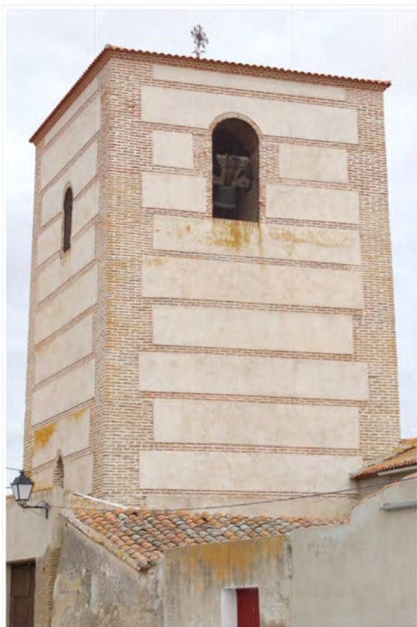
Fig. 10: costado SO de la torre de San Esteban de Zapardiel en el que se aprecia un hueco con un recercado singular; se produce un ensanchamiento antes del arranque del arco y todo el perímetro se ejecuta con un ladrillo de menores dimensiones que el resto. Es muy probable que esta peculiaridad sea producto del rellenos con ladrillo de la cavidad donde previamente se asentaran sillares para hacer rotar en ellos los ejes de una campana.
