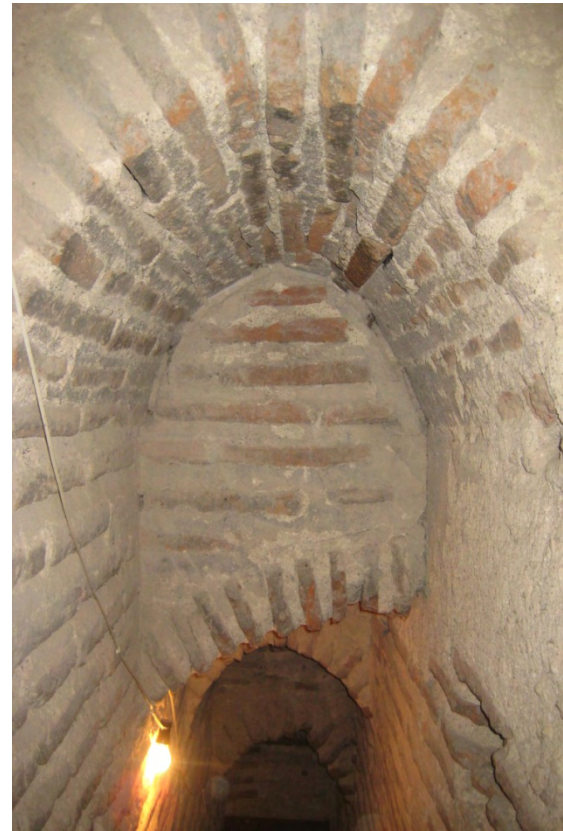
Fig. 13: sucesión de bóvedas de cañón que cubren el tramo de escaleras entre la primera y la segunda cámara.
