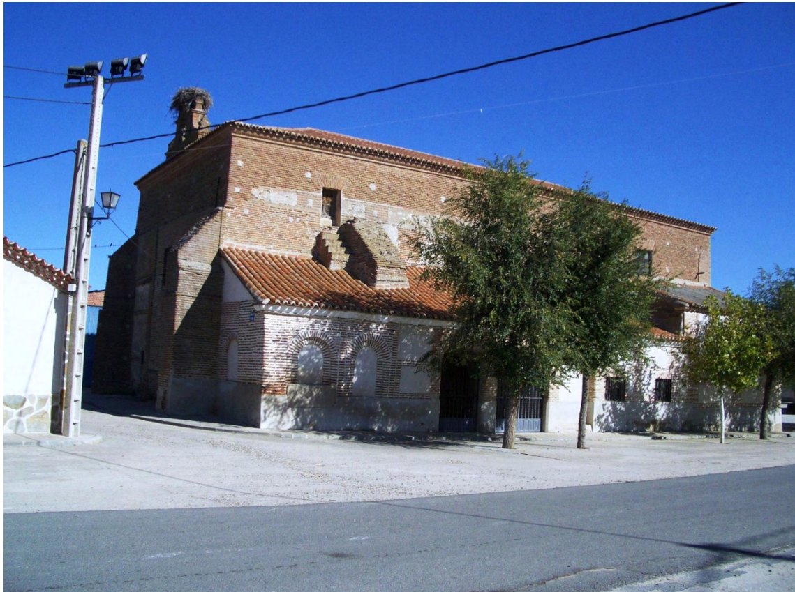
Fig. 3: iglesia parroquial de San Esteban de Zapardiel. Se aprecian en la esquina SO los arcos de medio punto de un fragmento de lo que debió de ser el pórtico al sur, único vestigio de traza mudéjar. Quedan tres arcos de medio punto, dos de ellos doblados. En la actualidad los huecos están tapiados por lo que el cuerpo ha perdido el carácter de pórtico.
