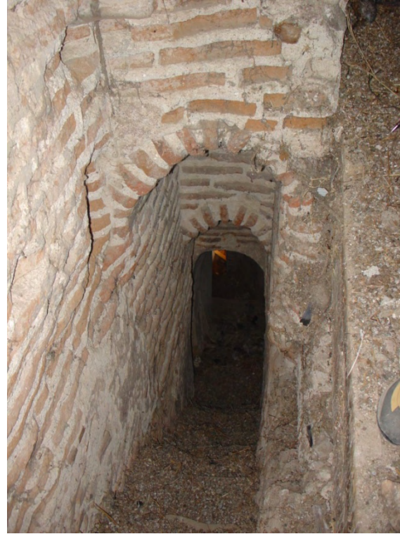
Fig. 25: sucesión de bóvedas de cañón que cubren el primer tramo de escaleras, que comunica la parte superior de la primera cámara con la segunda.
