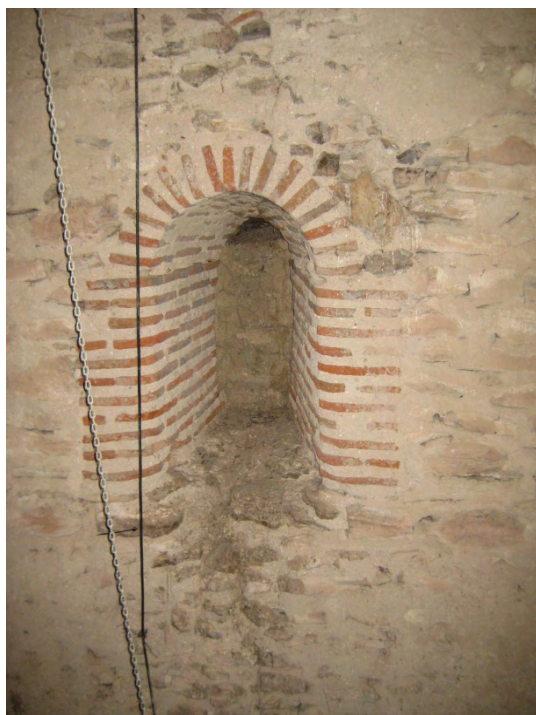
Fig. 16: ventana de la primera cámara. En la fotografía se aprecia cómo el abocinamiento no continúa hasta alcanzar el final del muro, sino que se interrumpe antes del murete de adobe que la clausura. Es muy posible que haya un espacio hueco detrás cuya finalidad desconocemos.
