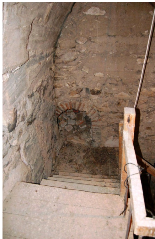
Fig. 14: puerta de acceso al tramo de escaleras comprendido entre la segunda cámara y el cuerpo de campanas. Sólo es visible la parte del arco al quedar oculta por la estructura de la escalera el resto de la traza.
