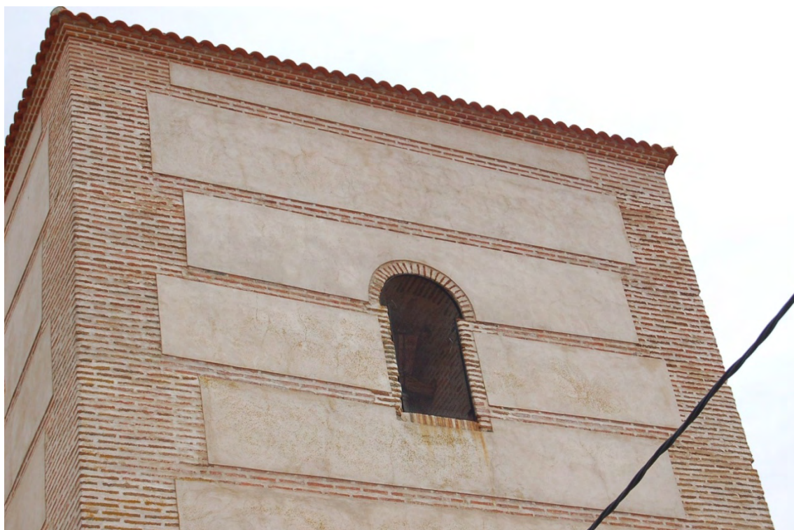
Fig. 9: Detalle de la ventana en la fachada NO. Un examen del recercado exterior permite apreciar la discontinuidad entre el ladrillo que lo conforma –que ya existía en el estado previo- y las verdugadas de origen medieval.
