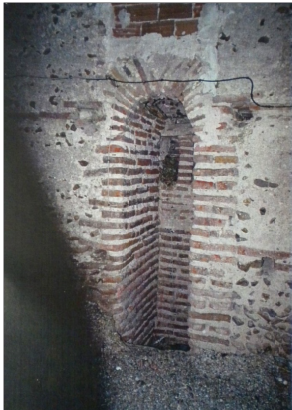
Fig. 58: abertura en la primera cámara desde la que se accedía a ésta tras haber superado el primer tramo de escaleras.
