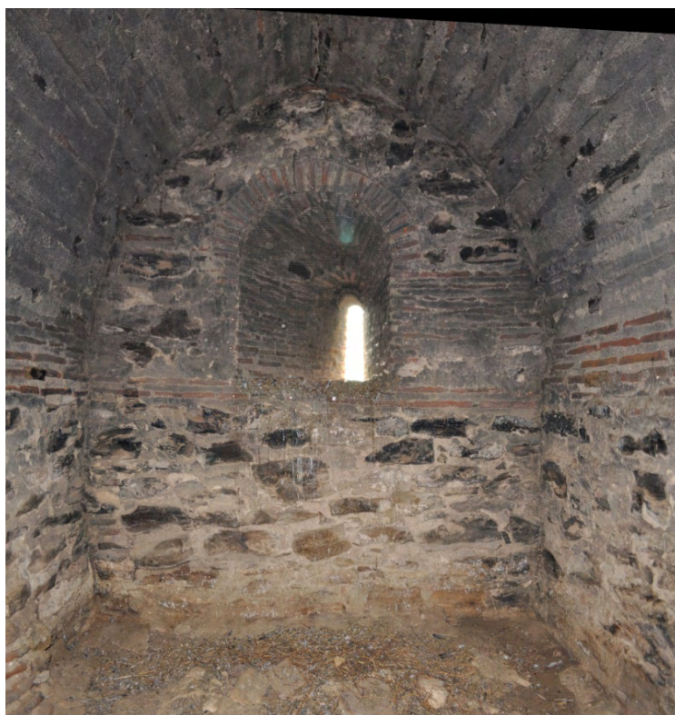
Fig. 42: vista de la segunda cámara con la ventana abocinada en la cara sur de la torre. El hueco se sitúa en el lugar típico en estas torres: centrado en el paramento plano a eje con la clave de la bóveda. Se resuelve con arco de medio punto. Se trata del único elemento (junto con la ventana análoga de la cámara inferior) que presenta esta forma, siendo apuntados el resto de elementos arcuados de la torre.
