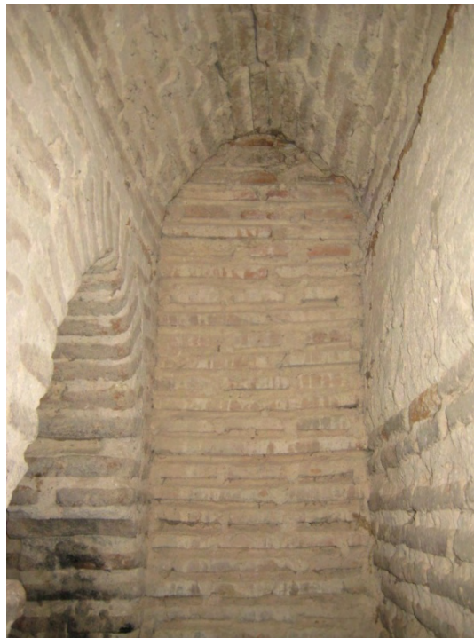
Fig. 23: Bóveda que cubre el arranque de la escalera que conducía desde el nivel de la segunda cámara hasta el cuerpo de campanas. El elemento se encuentra clausurado con fábrica de ladrillo.
