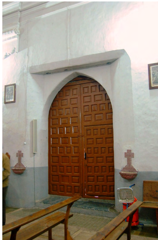
Fig. 8: desde el interior de la iglesia se aprecia el particular perfil apuntado de la puerta de entrada, centrada en el muro sur, que podría corresponder al ingreso original mudéjar.
