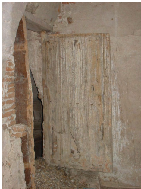
Fig. 18: puerta de acceso a la primera cámara. Se sitúa junto al arranque del primer tramo de escaleras embutidas en el muro y conserva las jambas originales. El arco típico con rosca de ladrillo a sardinel debe de estar bajo el relleno de mortero de cemento que hay sobre el dintel de la puerta actual.
