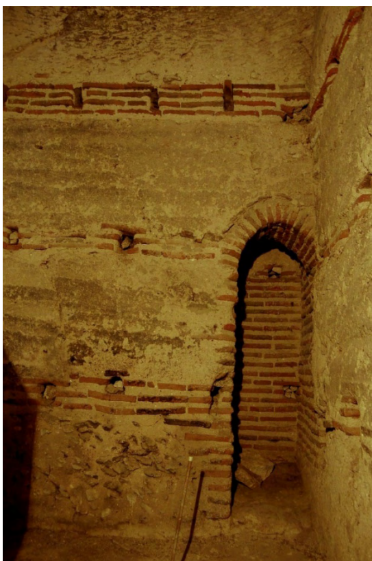
Fig. 14: puerta que accede al tramo de escaleras que comunicaba originalmente la segunda cámara con el cuerpo de campanas.
