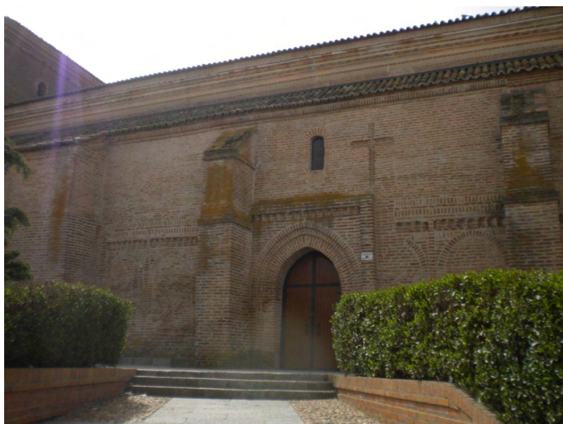
Fig. 14: pórtico norte de la primitiva iglesia mudéjar de San Julián y Santa Basilisa en Horcajo de las Torres. Contaba en origen con una serie de arcos de medio punto, que se condenan para crear un recinto cerrado al que se accederá mediante una puerta, ya apuntada, con un programa decorativo igual al de la entrada de la torre de San Nicolás de Bari. En la secuencia constructiva del paramento se lee claramente, la transición del románico al gótico. El dato es de gran importancia porque las torres de Espinosa y la de Horcajo cuentan con un número importante de similitudes.
