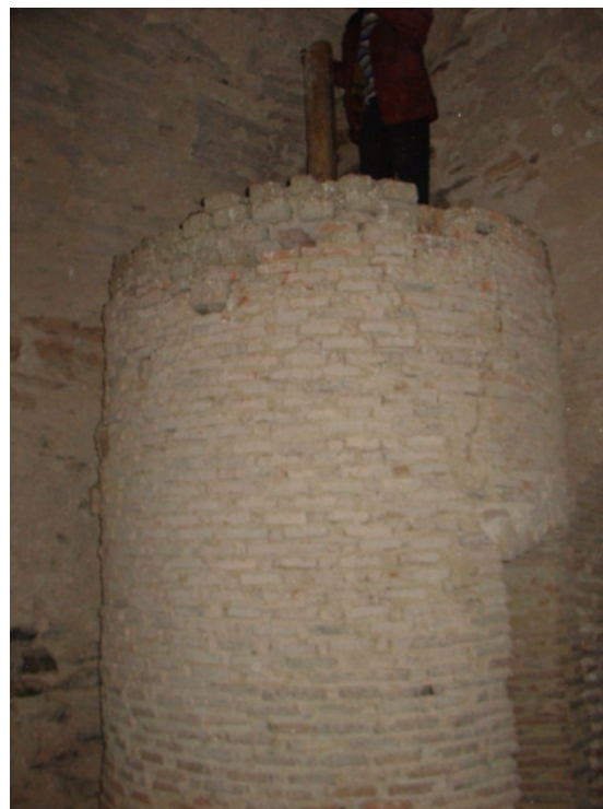
Fig. 12: cilindro de fábrica de ladrillo que aloja la escalera que comunica la cota de calle con el primer tramo de escaleras de fábrica embutidas en los muros.
