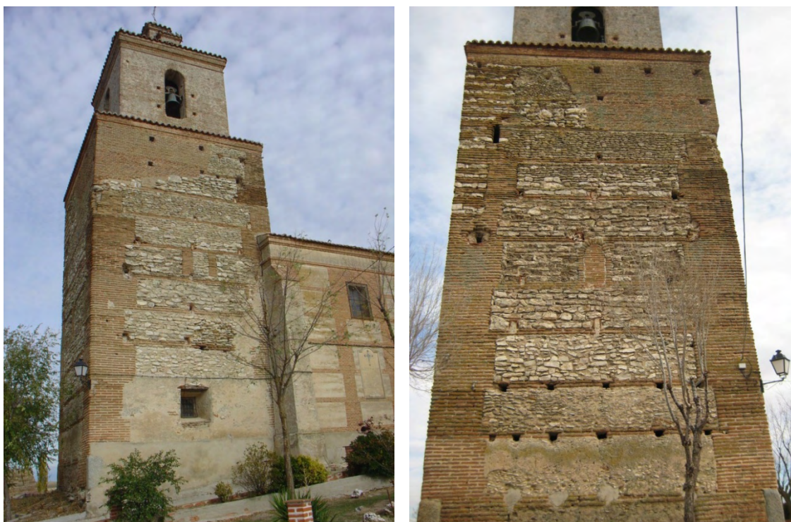
Fig. 4: fachadas sur y oeste del fuste de la torre de Villanueva del Aceral. Se aprecia a simple vista la heterogeneidad de los estratos, que dificultará enormemente su lectura. Asimismo presenta una gran variedad de formas y tamaños en los mampuestos que rellenan sus cajones.
