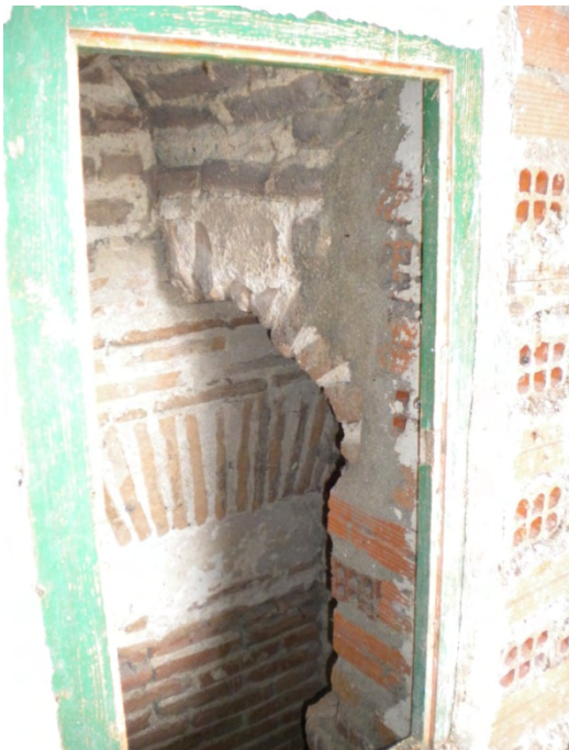
Fig. 32: dintel sobre la abertura que se practica en la fachada este para posibilitar la salida ocasional a las cubiertas de la iglesia para su reparación.
