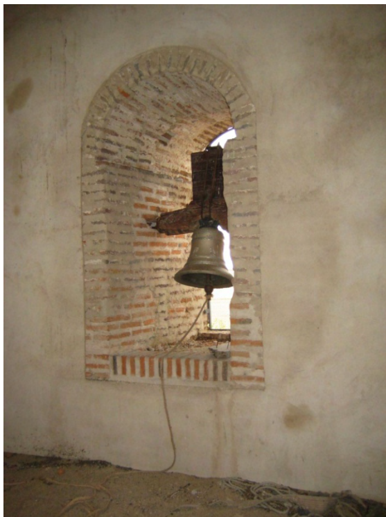
Fig. 30: ventana de la segunda cámara en la cara interna del muro noroeste. Es patente que el ladrillo con el que se voltea el arco es de gran antigüedad y, por tanto, anterior a la rehabilitación de la torre.
