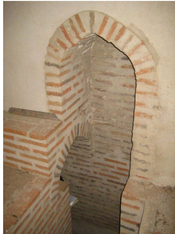
Fig. 27: desembarco del segundo tramo de escaleras en la cámara superior. El último arco y el sistema de acceso son de construcción reciente.
