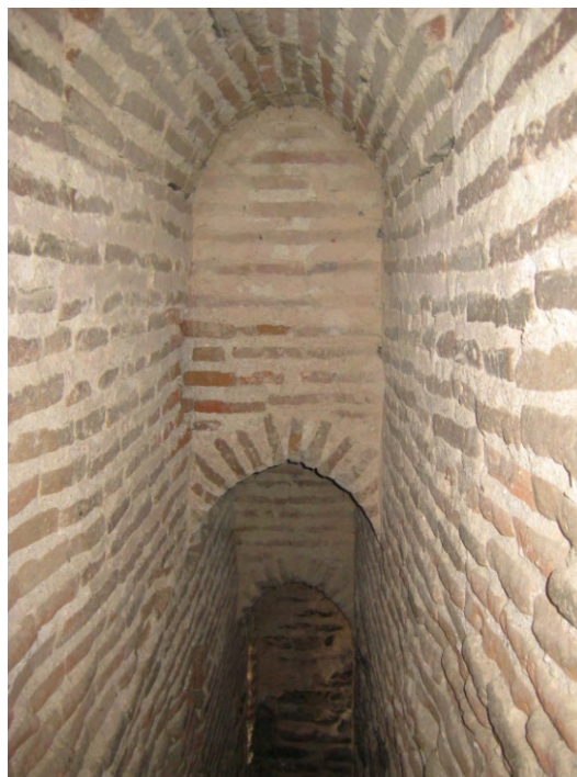
Fig. 19: sucesión de bóvedas de cañón con un ligero apuntamiento que comunican la parte de la bóveda de la primera cámara con el nivel de forjado de la segunda.
