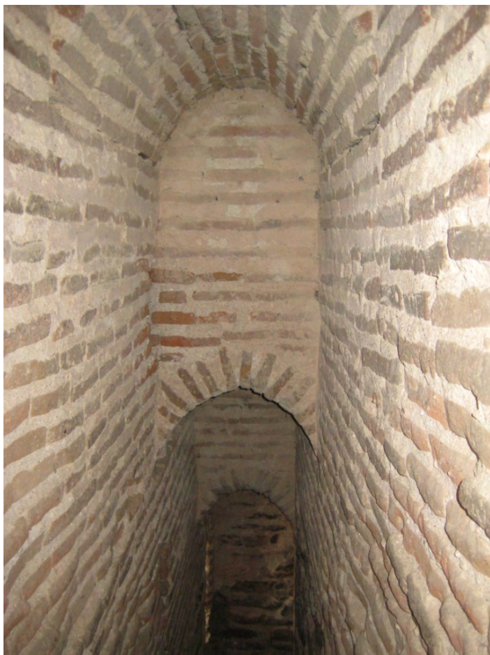
Fig.13: secuencia de arcos en el interior de la torre de Villanueva del Aceral. Se aprecia cómo la completa estructura de escaleras embutidas en el muro se construye con ladrillos dispuestos fundamentalmente a soga. Los ladrillos que conforman la bóveda se colocan sobre su canto largo de modo que éste sea paralelo al eje de la misma.
