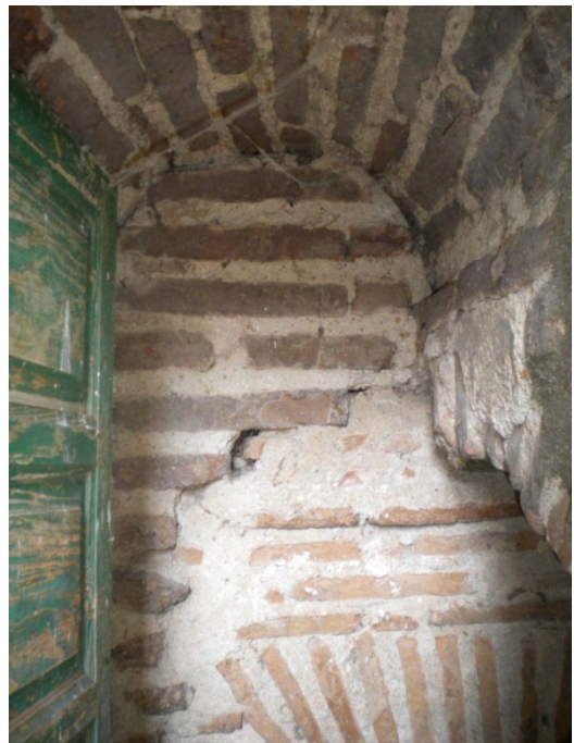
Fig. 33: bóveda perpendicular a la secuencia ascendente que cubre la escalera. Mediante esta bóveda se accede a la cota del suelo del cuerpo de campanas de la torre.
