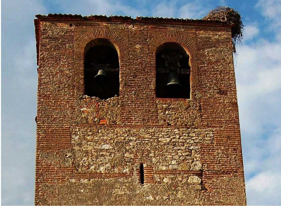
Fig. 47: remate de la torre de la iglesia de Santo Domingo de Silos, en Codorniz, en el que se aprecia la estructura de machones verticales en continuidad con la fábrica original que después se colmatan para configurar los actuales huecos de campanas.
