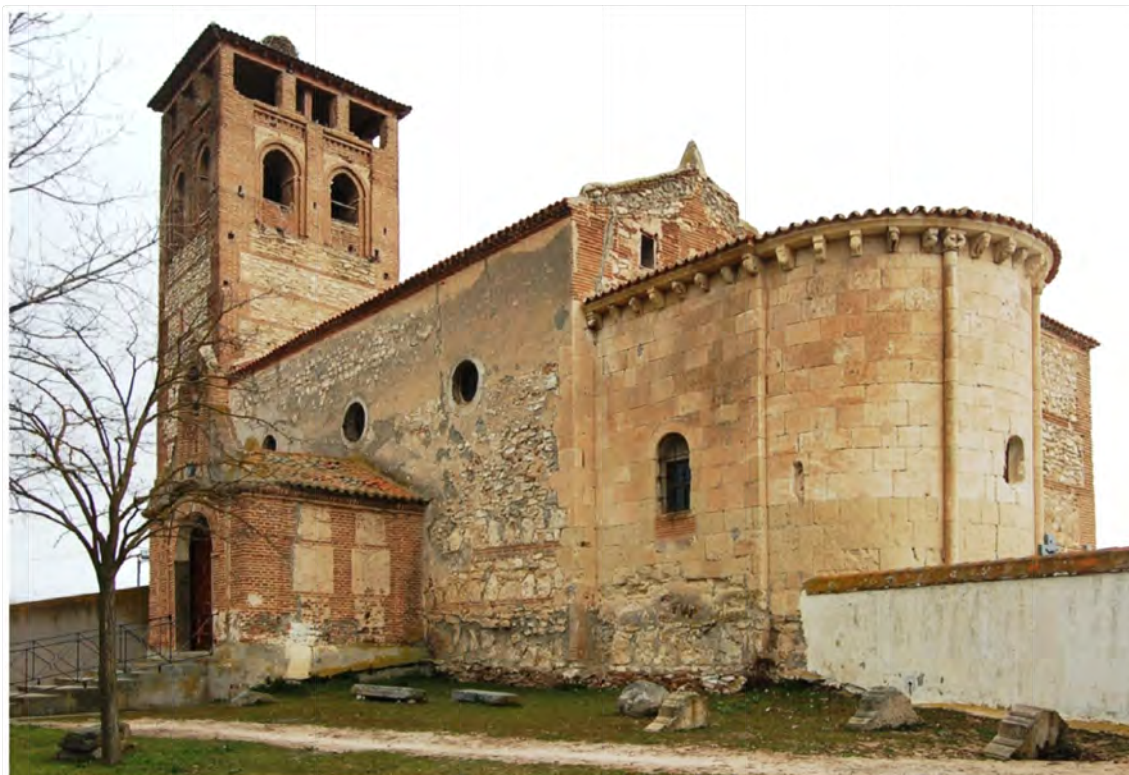
Fig. 5: iglesia parroquial de San Andrés en Espinosa de los Caballeros. Se observa en la fotografía la adaraja de sillería del ábside que traba con el muro original del templo por el costado sur. También existe continuidad en los materiales de cimentación y en la piedra sin desbastar del basamento de ábside y muro sur.
