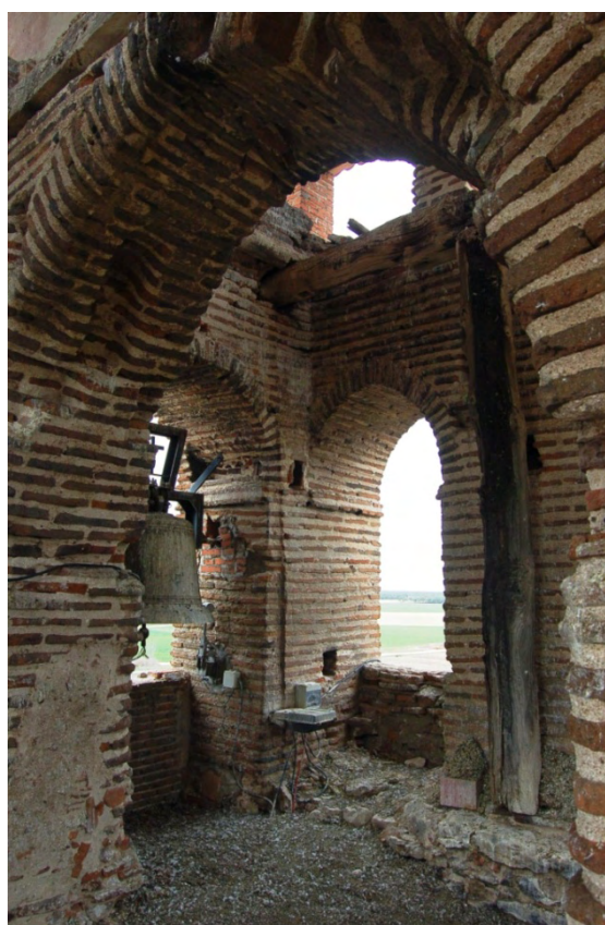
Fig. 47: rincón noroeste del cuerpo de campanas en el que se aprecia la coherencia constructiva respecto al exterior. Los arcos apenas han sufrido modificaciones. Todo indica que el campanario pertenece a la misma actividad constructiva que el resto de la torre.
