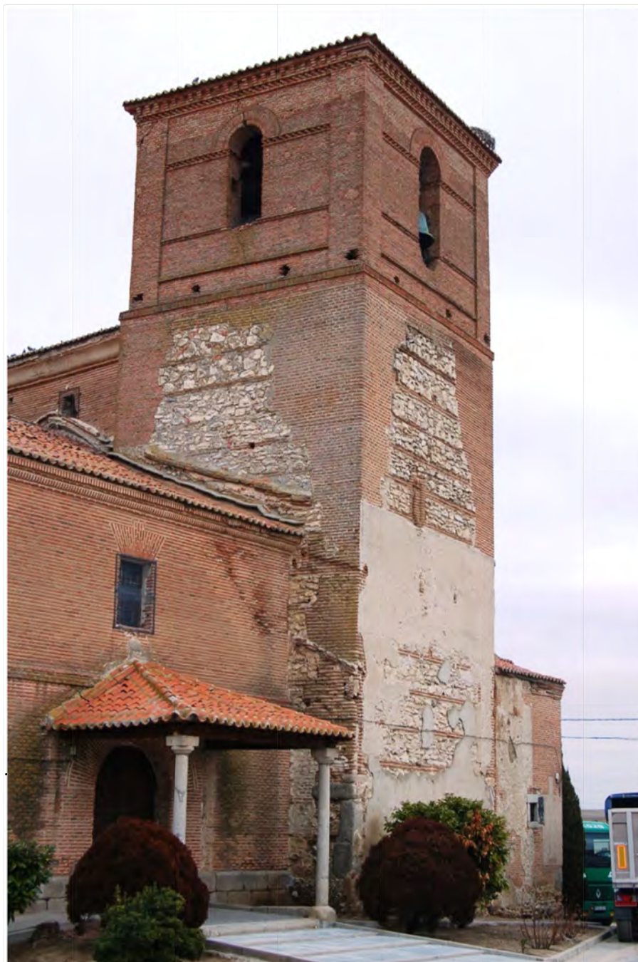
Fig. 5: torre de la iglesia parroquial de Sinlabajos. Flancos sur y o este. En la fachada sur se aprecia claramente el hueco mudéjar enmarcado con alfiz y en la oeste, junto a la cornisa del cuerpo de entrada a la iglesia, se ve parcialmente otra, de dimensiones muy similares, cegada.
