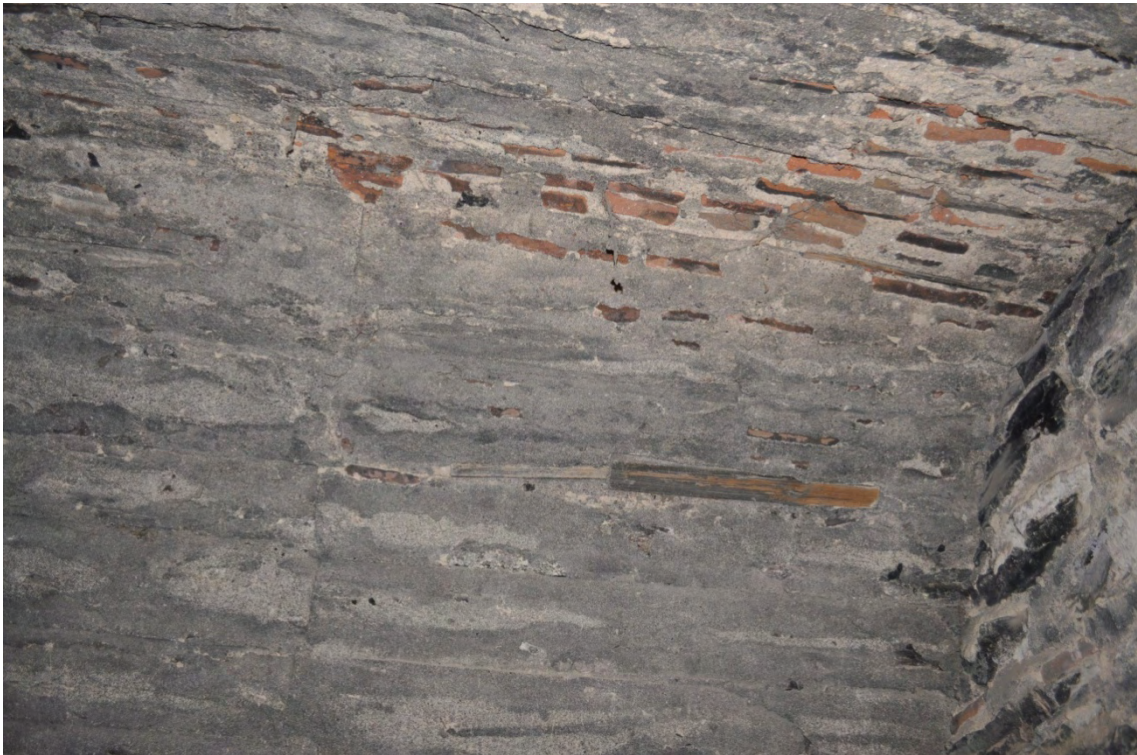
Fig. 23: Segunda cámara de la torre de Espinosa de los Caballeros en la que se aprecia la textura. De los tablonces de madera que constituyeron el encofrado, uno de los cuales aún permanece adherido al intradós. Las bóvedas de esta torre se voltean enteramente con ladrillo, aunque en muchas partes haya quedado oculto tras la lechada de cemento que, por gravedad descende desde la argamasa fresca y queda retenida por el entablamiento.
