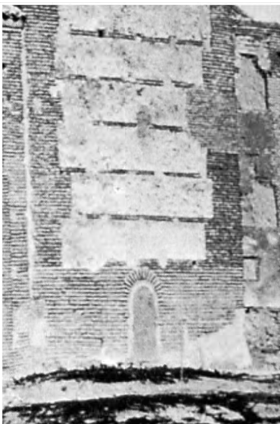
Fig. 18: puerta de la torre desaparecida de Horcajo de las Torres. Al igual que la de Espinosa se halla a cota del terreno y centrada en el paramento. También se encuentra situada en el flanco oeste.
