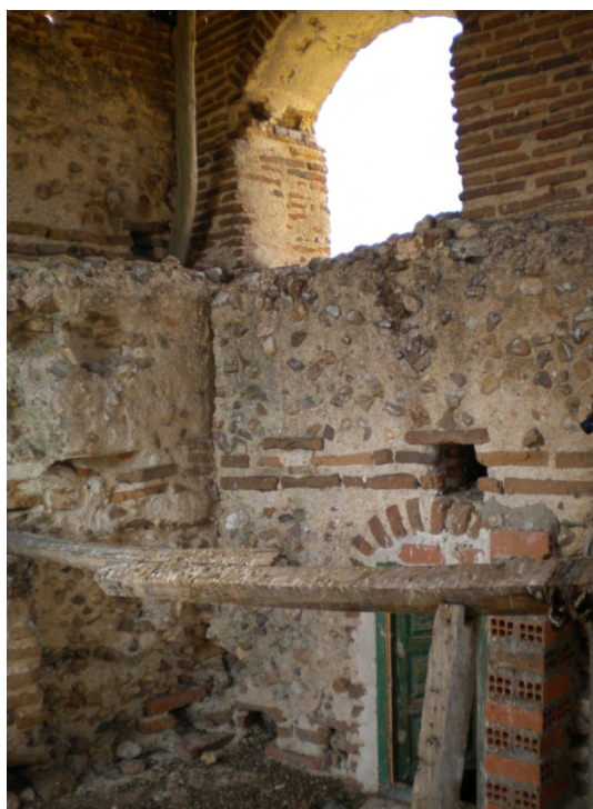
Fig. 35: puerta de salida al cuerpo de campanas desde la escalera de fábrica. En la fotografía se aprecia la relación entre la puerta y el muro que la contiene. La salida se realiza por el único muro del campanario que no está recrecido.
