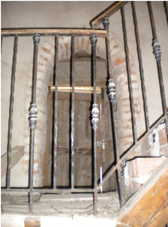
Fig. 18: puerta original de acceso a la torre hacia el interior de la torre. Todo el recercado es de ladrillo original. Se ingresa a través de una perforación abovedada en el muro cuya sección es la de un arco apuntado.
