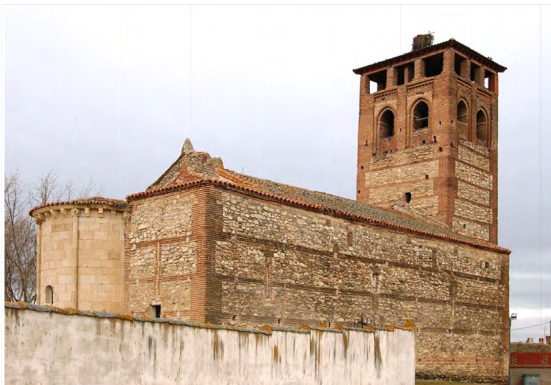
Fig. 6: El adosamiento del muro norte se trata claramente de una intervención posterior a la de la ejecución del ábside. El muro norte primitivo, que conformaba el templo con una única nave existe en la actualidad y es visible desde el interior, aunque perforado por dos arcos y enlucido. El muro exterior que se ve en la fotografía monta sobre uno de los canchillos románicos ocultándolo parcialmente.
