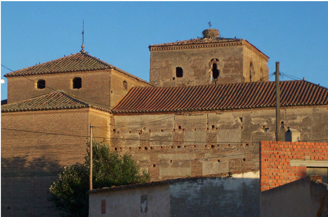
Fig. 11: fachada norte de la iglesia de Castellanos de Zapardiel. Se aprecia la parte superior de la torre en la que se observan los huecos tan intervenidos que dificultan plantear cómo debieron de ser en origen.
