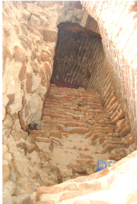
Fig. 9: Interior del huevo sobre la fachada norte. Se aprecia en la fotografía la bóveda de cañón correspondiente a la tipología de acceso a estas torres.
