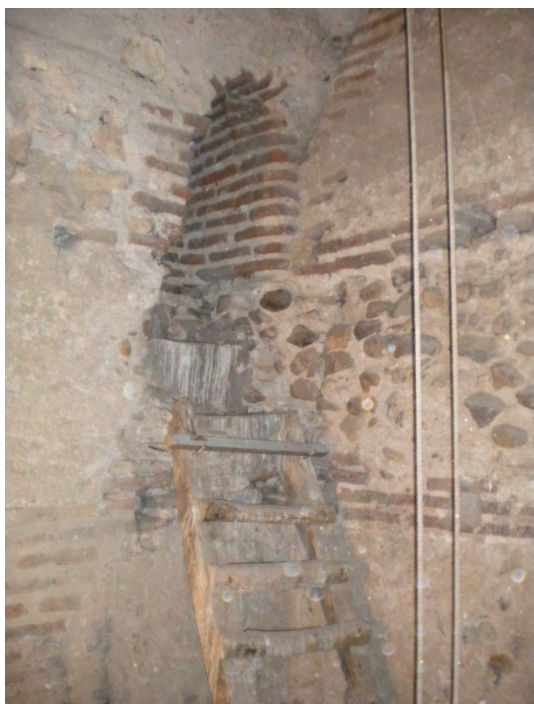
Fig. 28: puerta por la que se accede al primer tramo de escaleras se sitúa en la cara interior este de la torre y está a cierta altura sobre la cota de forjado. Para alcanzar la cota se utiliza una rudimentaria escalera de madera.
