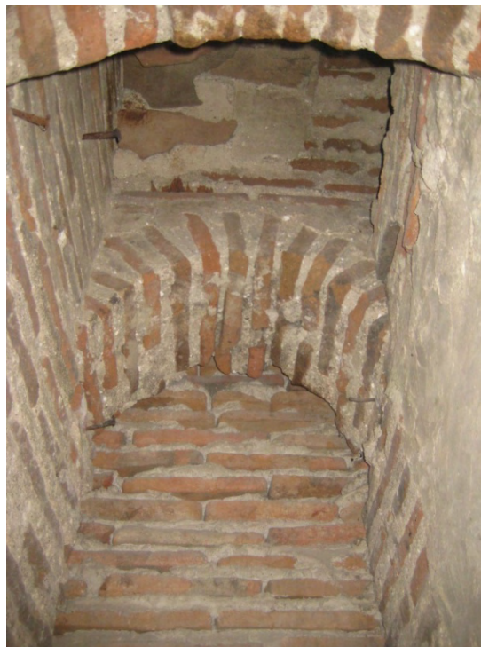
Fig. 12: primer tramo de la escalera embutida en el muro (dentro de la cavidad) que comunicaba la primera cámara con la segunda.
