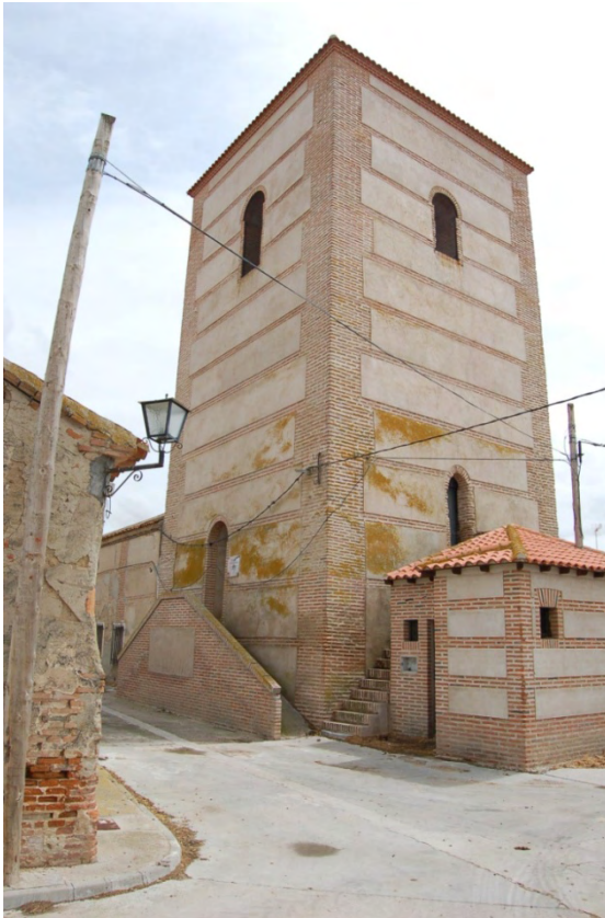
Fig. 6: costados NO y Ne de la torre de San Esteban de Zapardiel. En la fachada NO, centrada en el muro y con perfil apuntado se ve la puerta original de acceso a la torre.
