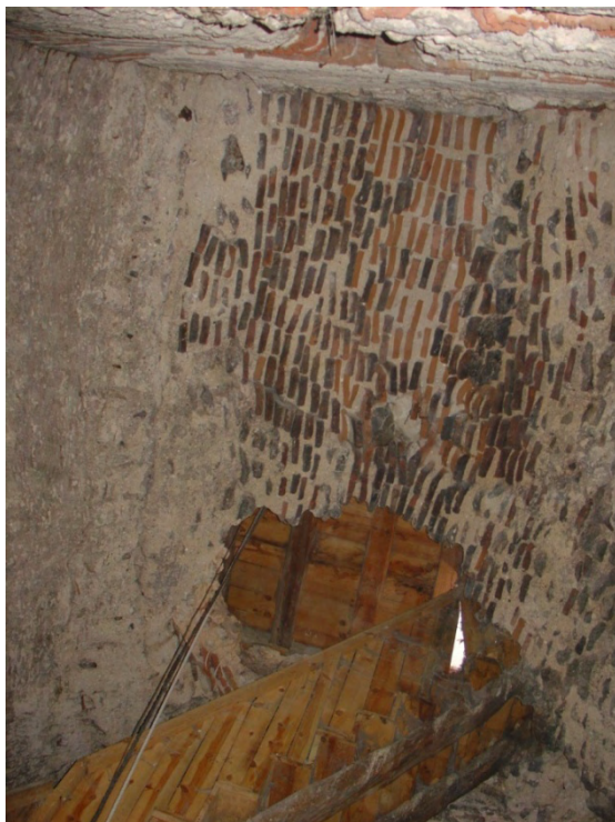
Fig. 18: rotura de la bóveda de la segunda cámara para insertar la escalera nueva que lleva desde el nivel del suelo de esta estancia hasta el forjado del cuerpo de campanas.
