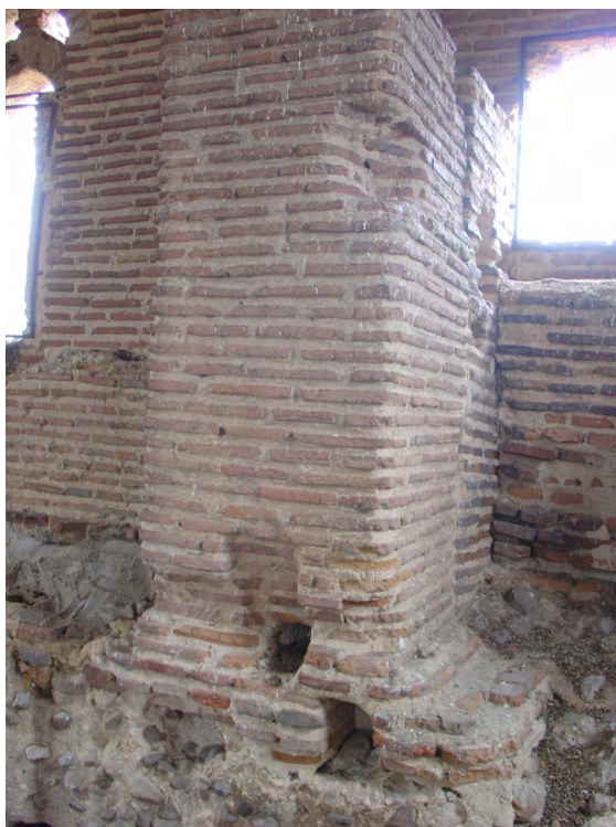
Fig. 29: cara interna del campanario en el costado norte. Se aprecia cómo existe un corte en la fábrica que se adosa al muro, junto al hueco de la ventana y la del machón que lo refuerza.
