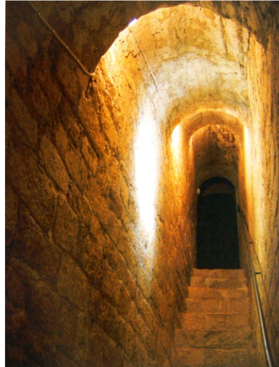
Fig. 5: bóvedas escalonadas que comunican el cuerpo inferior y el superior de la parte del complejo correspondiente a los siglos XI y XII. En este caso, se resuelve con mampostería, en vez de con ladrillo.
