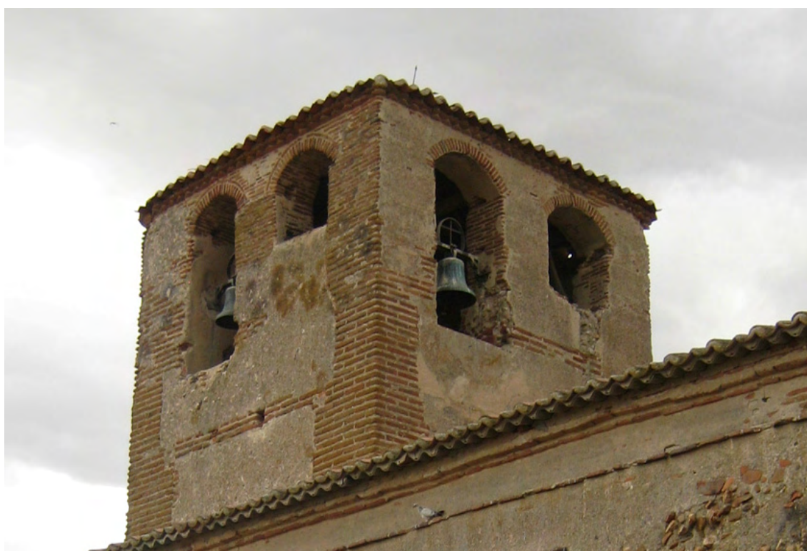
Fig. 16: flancos sur y este del campanario. El patrón de apertura de los huecos es muy similar y parece estar resuelto con arcos del mismo tipo, sin embargo una observación detenida permite notar que el aparejo no es exactamente igual, por lo que podemos asegurar que no se ejecutan simultáneamente.
