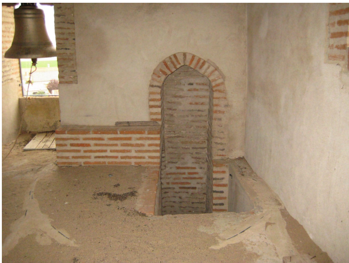
Fig. 28: sistema de acceso a la cámara superior que horada parte del forjado para salvar la distancia entre el final del segundo tramo de escaleras y la cota del suelo de la cámara. No es habitual acceder de esta forma a las cámaras. En el resto de torres estudiadas la puerta se abre en el muro encontrándose el último peldaño a cota con el forjado de la cámara a la que se accede.
