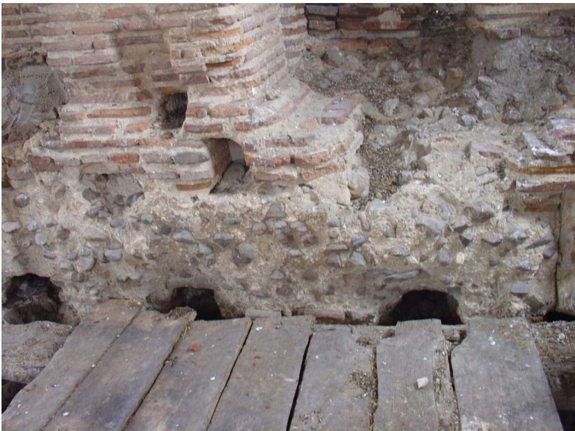
Fig. 34: nivel del actual forjado de madera del cuerpo de campanas. En el machón vertical, un poco por encima, se ve un mechinal en cuyo interior quedan restos lígneos. A esa altura se dispone el forjado hipotético que serviría como base transitable para la zona almenada
