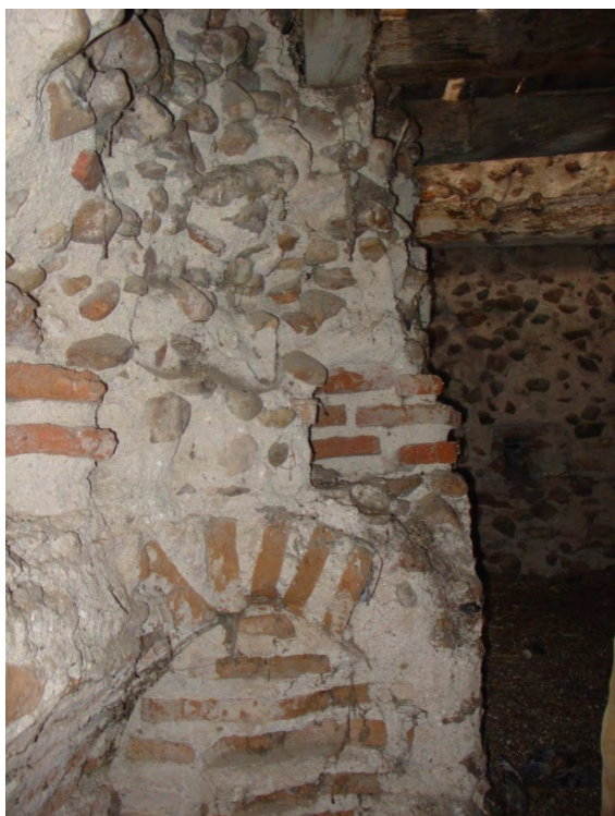
Fig. 28: bóveda fracturada en la segunda cámara que demuestra que continuaban ascendiendo las escaleras probablemente hasta el nivel del cuerpo de campanas.
