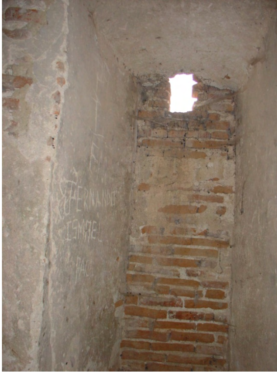
Fig. 24: hueco sobre la fachada oeste tapiado y con una pequeña abertura para el paso de la luz.
