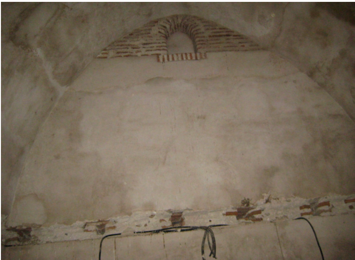
Fig. 21: cara interna del lado sudeste. Parte superior de la cámara inferior de la torre de San Esteban de Zapardiel. En esta cara se encuentra la única ventana original de época mudéjar. Mientras que podemos asegurar que el recercado de las jambas y el arco son originales, no existe la certeza de que la composición del alféizar también lo sea.
