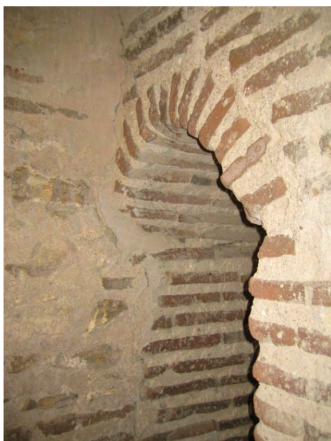
Fig. 20: Desembarque del primer tramo de escaleras que se realiza mediante puerta abovedada ejecutada en ladrillo. El perfil es semicircular.
