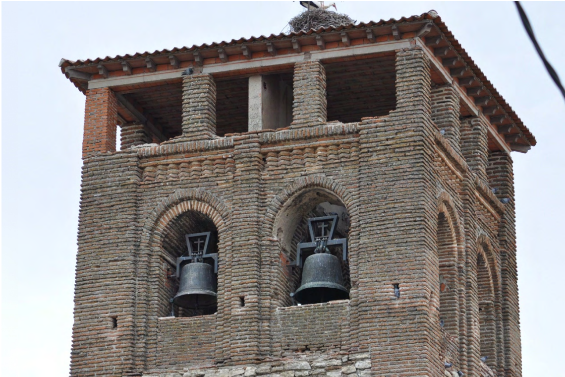
Fig. 24: detalle del cuerpo de campanas. Excepto en la tosca y reciente reposición de la columnilla de la esquina noroeste, las demás parecen presentar continuidad con el resto de la fábrica medieval.
