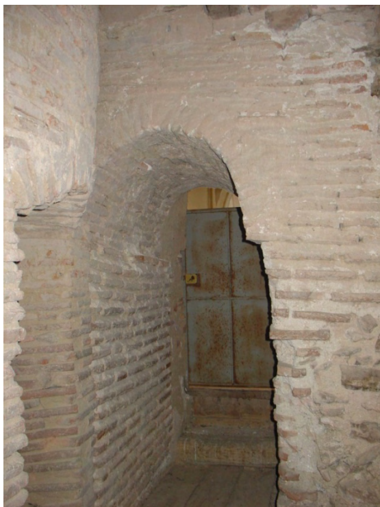
Fig. 11: puerta que daba acceso originalmente a la torre. Hoy en día comunica el nivel del forjado de la primera cámara con el coro situado a los pies de la iglesia. Se construye mediante bóveda de cañón de perfil perfectamente semicircular, sin ningún indicio de apuntamiento.
