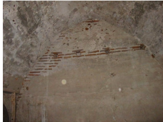
Fig. 21: cara interna de la primera cámara en el costado norte. Se observa el notable apuntamiento de la bóveda, las huellas del encofrado que se utilizó para conformar las bóvedas y las verdugadas de ladrillo que confinan uno de los cajones.
