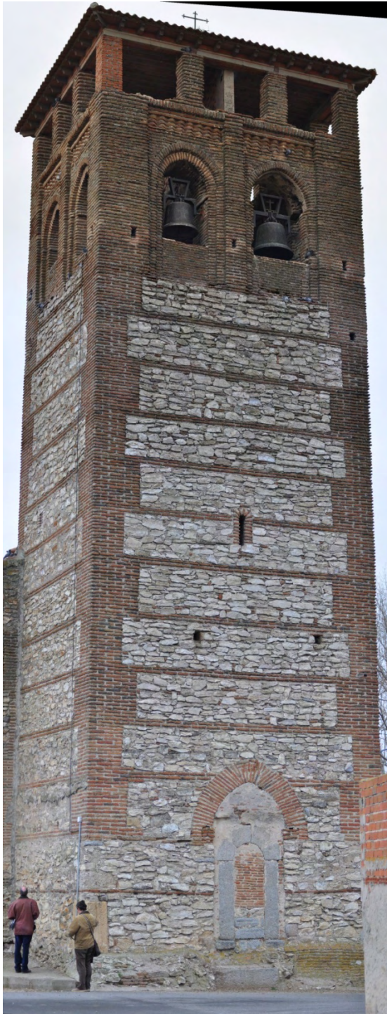
Fig. 22: fachada oeste de la torre de Espinosa de los Caballeros
