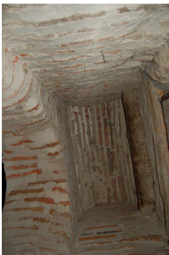
Fig. 24: bóveda de cañón cegada. Se halla en el ingreso a la torre, a mano a izquierda. Es el elemento con el que se cubre el arranque del primer tramo de escaleras en el interior del muro NO, por lo que tenemos la certeza de que el ascenso se iniciaba en ese punto.
