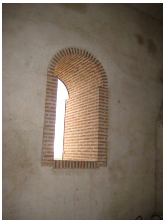
Fig. 33: ventana de la segunda cámara en la cara interna del muro sudeste. El hueco está completamente rehecho en la rehabilitación última y se ejecuta emulando las características del hueco de la fachada noroeste.
