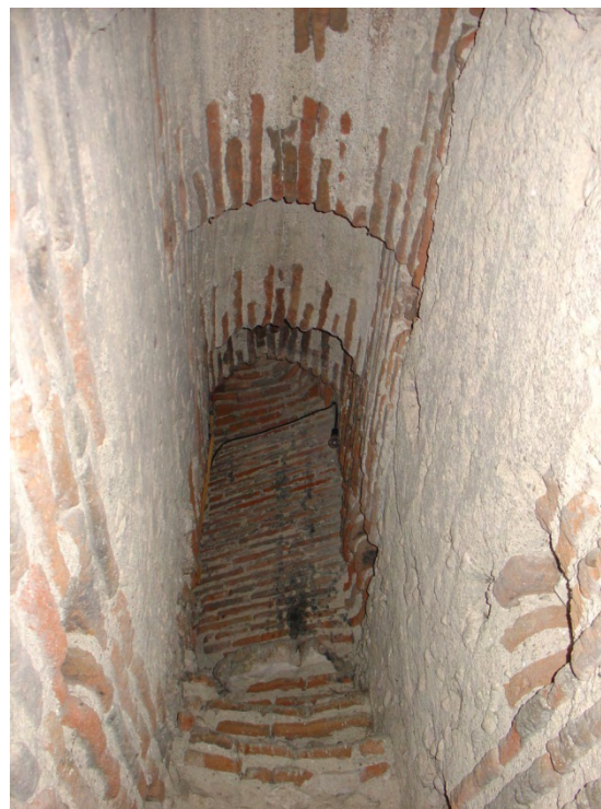
Fig. 19: final del tramo de escaleras encastrado en el muro norte. Se aprecia cómo se condena al final del espacio el acceso al tramo siguiente, que ascendía por el muro oeste hasta el campanario.
