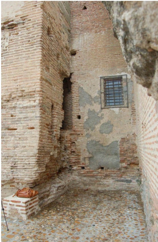
Fig. 8: Huevo parcialmente oculto en la fachada norte de la torre de Castellanos de Zapardiel. Se trata de la puerta original que daba acceso al edificio.
