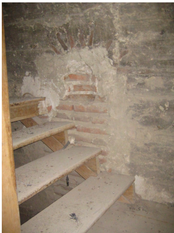
Fig. 16: hueco en la parte central del muro oeste de la torre. Trazas localizadas en la primera cámara de la sección C-C. Este hueco tenía una doble función: por un lado iluminaba el tramo de escaleras embutido en el paramento oeste de la torre que conducía de la primera a la segunda cámara y simultáneamente suponía un foco de iluminación secundaria para la primera cámara.
