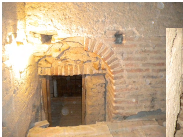
Fig. 25: puerta de acceso a la que hoy es la parte superior de la primera cámara. En la foto se aprecia parte del arco de la puerta original y al fondo se ve el nivel del coro, por debajo del nivel del forjado de este recinto. Queda claro en la imagen que la puerta se prolongaba por debajo del nivel actual de este forjado. El perfil que describe la impronta de los ladrillos en la argamasa es el de prácticamente un arco de medio punto.
