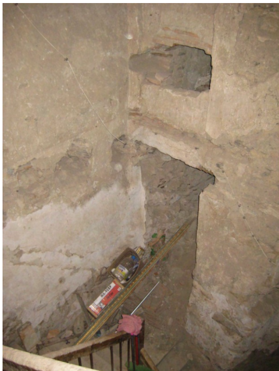
Fig. 11: abertura en el muro (trazas visibles en la sección A-A) que permite acceder al primer tramo de escalera embutida en el muro cubierta con bóveda de cañón escalonada.
