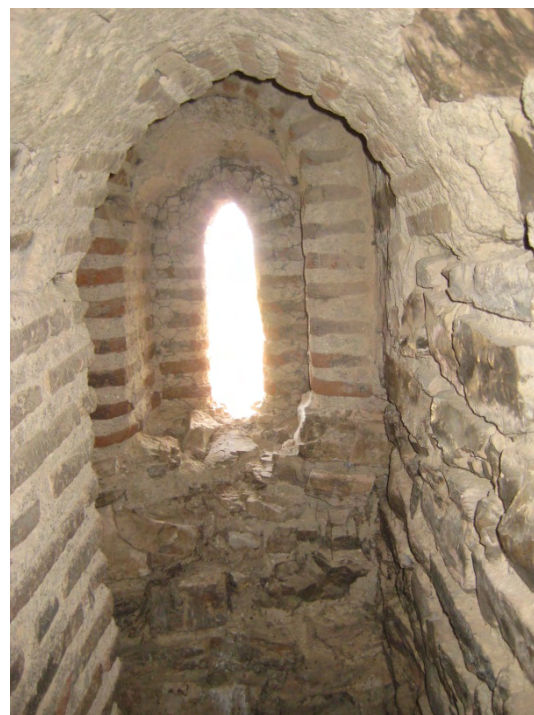
Fig. 17: puerta abierta en el muro norte de la primera cámara a una altura de 2.90 m sobre la cota de su forjado que da acceso al primer tramo de escaleras embutidas en el muro. Se trata de una estructura abovedada de cañón apenas apuntado.
