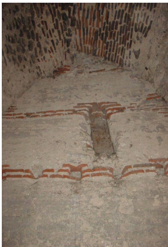
Fig. 15: ventana en la segunda cámara, sobre el muro este construida mediante el sistema de falso arco a base de ladrillos escalonados apoyados sobre sus tablas.
