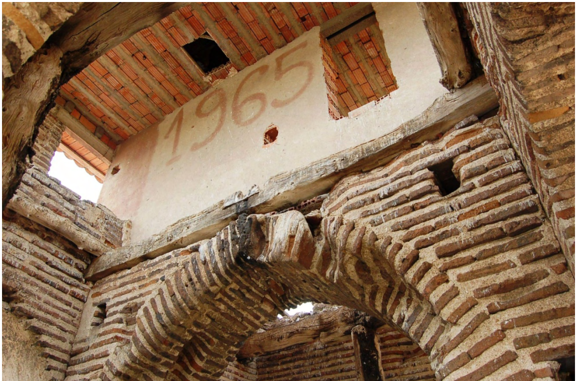
Fig. 48: parte superior del arco ligeramente apuntado en el interior del campanario. Sobre él se construye un murete de un pie de ladrillo hueco doble y se cierra con un forjado de vigueta plementada con ladrillo hueco.
