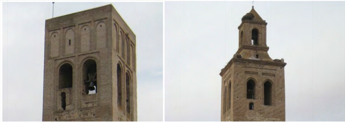
Fig. 38: En las imágenes se observa el detalle de los campanarios de la torre nueva de San Martín–izquierda- y de la torre de Santa María –derecha, ambas en Arévalo. En los dos casos, se reduce el hueco original mediante un arquillo que se adosa en la cavidad con el fin de alojar una campana de menor tamaño.
