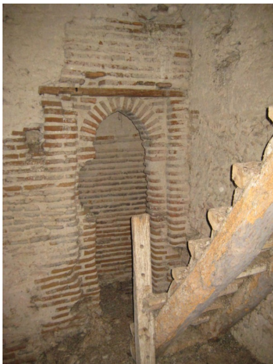
Fig. 22: puerta que da acceso a la segunda cámara. Presenta la decoración tan típicamente mudéjar del enmarcado con alfiz y arco de herradura ojival, motivo poco frecuente en las arquitecturas de la zona.
