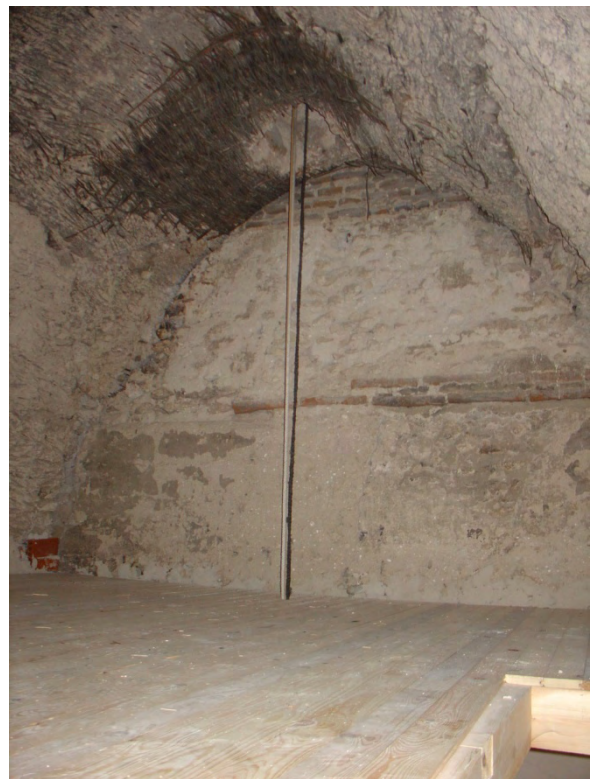
Fig. 10: Bóveda de cañón de la primera cámara en la que se aprecian los restos del entramado de mimbre que servían para facilitar el descimbrado.
