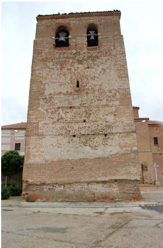
Fig. 6: Fachada sur de la torre de Castellanos de Zapardiel. En ella se aprecia el hueco típico en aspillera centrado cerca de la clave de la primera cámara. También se aprecia el tamaño desigual de los huecos de las campanas así como las piedras que se labran en 1670 para encajar los ejes de las campanas.
