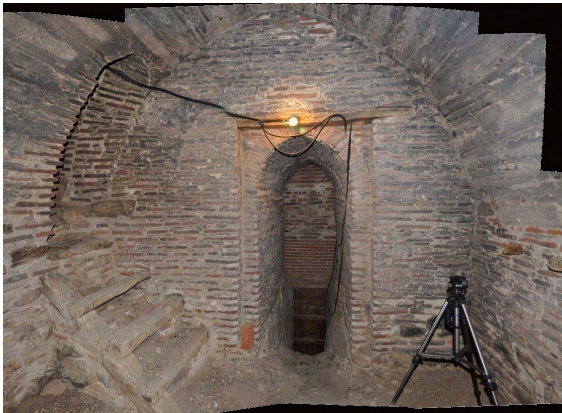
Fig. 37: Primera cámara. Se observa centrada al fondo, a juna cota inferior a la de la estancia, una puerta de madera. El nivel original de acceso es el marcado por el del suelo de esta cámara y para alcanzarlo es necesario ascender por unas toscas escaleras que se asientan sobre el conducto excavado a pico en el muro este de la torre. Este conducto comunica el nivel del coro de la iglesia con el de esta primera cámara.
