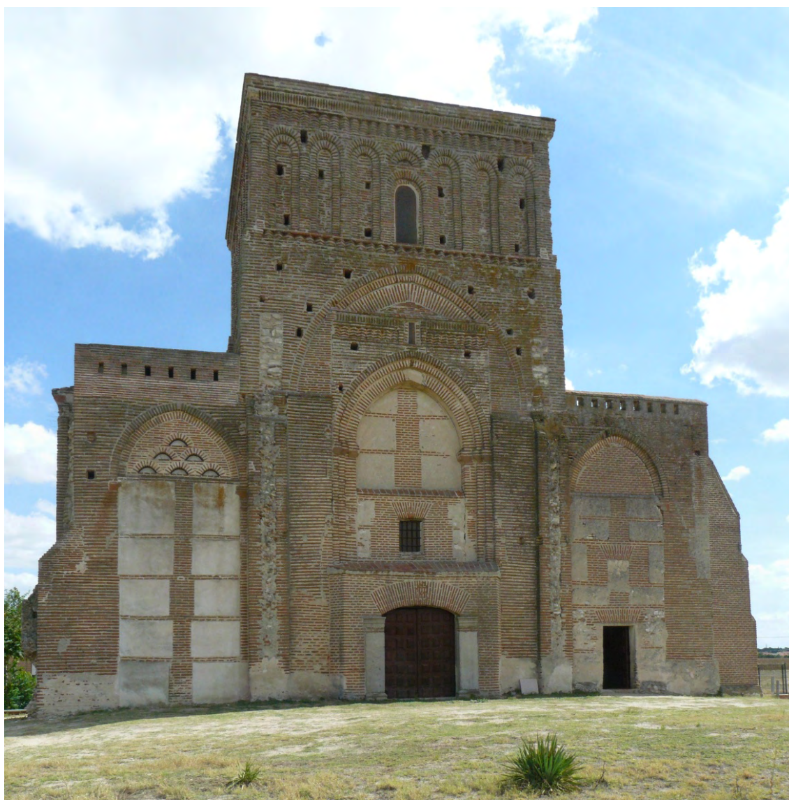
Fig. 15: costado oeste de los restos del monasterio de Santa María de la Lugareja en Arévalo. En la imagen se aprecia la estructura del gran arco que genera la nave central con la misma composición que el medieval de la torre de San Nicolás de Bari y el del cierre del pórtico norte de Horcajo de las Torres. Se trata de un arco con triple rosca de ladrillo, con una proporción 2:1:1, es decir, se construye con una soga de ladrillo la rosca interior y con sendos tizones las dos más externas. Sobre el arco, un friso de esquinilla con dientes compuestos por tres juntas y dos ladrillos.
