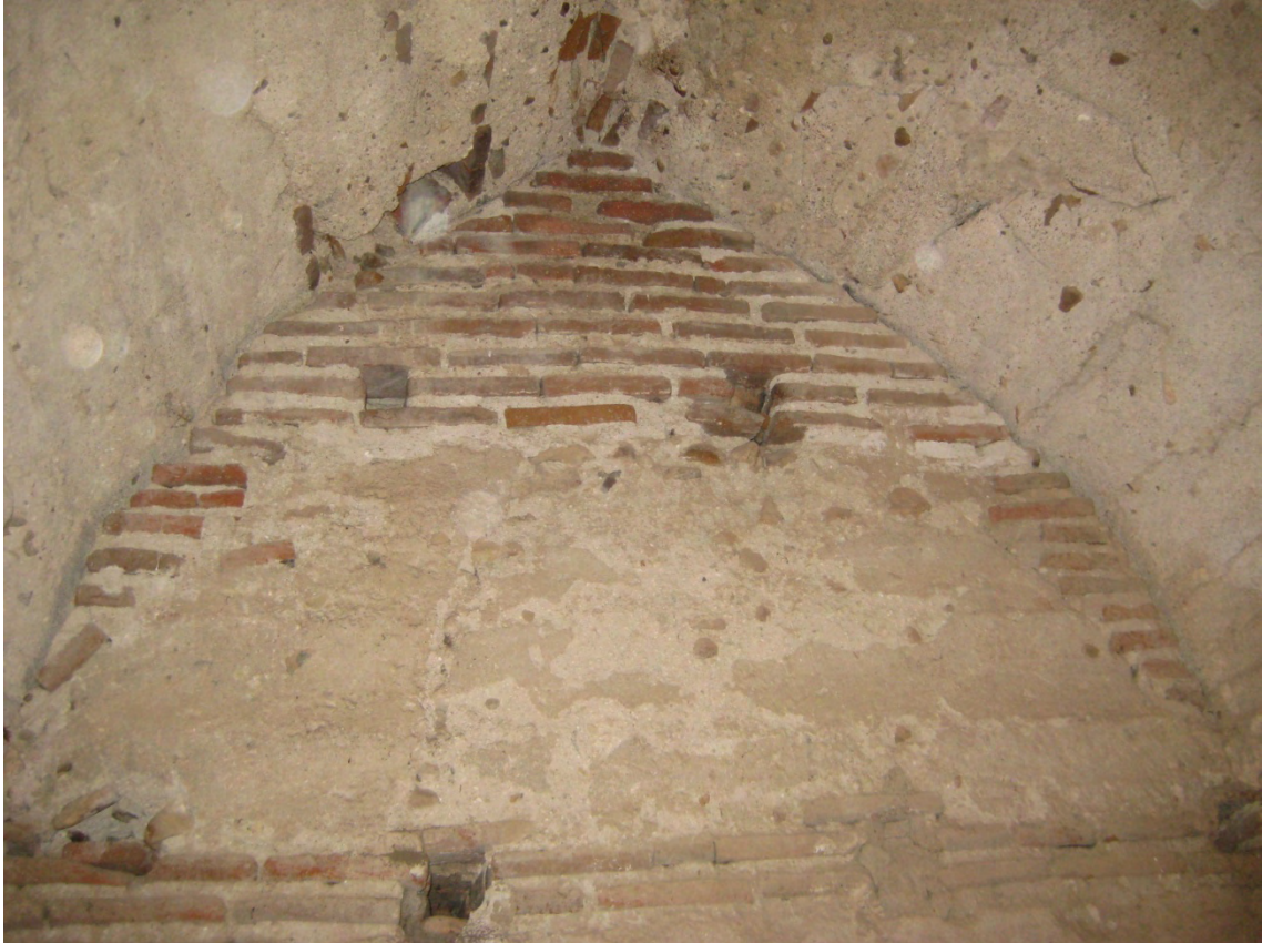
Fig 27: cara interior norte de la primera cámara. Al igual que en la pared que tiene enfrente, se observa el remate de ladrillos en la parte superior. Son asimismo visibles las huellas de los tablones que sirvieron de encofrado para la bóveda. Se aprecia en esta imagen lo acusado del apuntamiento de la bóveda de cañón.
