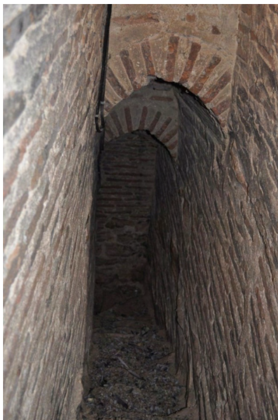
Fig. 44: tramo de escaleras que asciende desde la segunda cámara hasta el cuerpo de campanas, horadando el muro norte. Se observa el marcado carácter apuntado de los arcos, muy homogéneos en todo el recorrido y la profusión con la que se utiliza el ladrillo en las paredes laterales.
