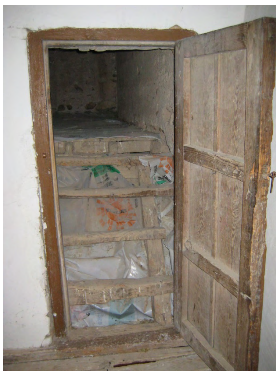
Fig. 23: puerta de acceso a la parte superior de la primera cámara. En la fotografía se ve la tosca escalera de madera que salva la altura entre la cota del coro y la del forjado de esta primera cámara. La cota del coro debió de ser también la del arranque de la puerta de acceso a la torre. Esta cavidad corresponde parcialmente con la entrada original a la torre.
