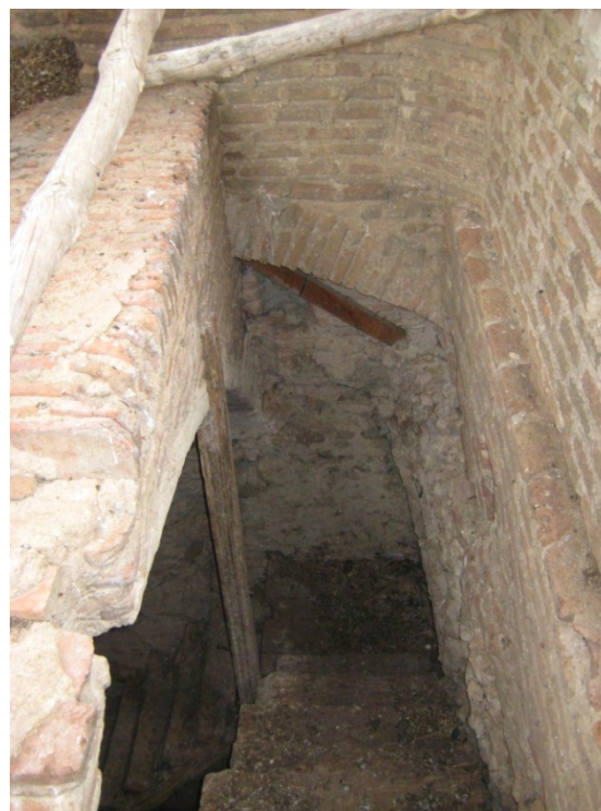
Fig. 25: espacio que queda entre el final de la bóveda que cubre la segunda cámara y el paramento para dejar abierto el hueco por el que asciende la escalera por la que se alcanza en la actualidad el cuerpo de campanas.
