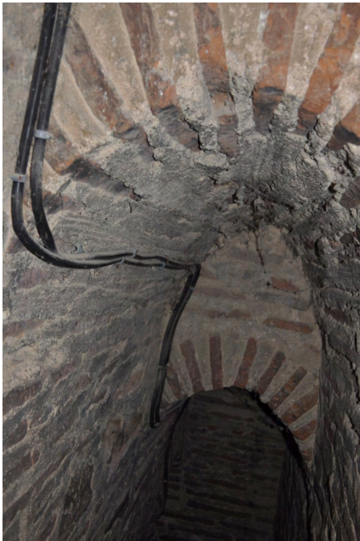
Fig. 24: Tramo de bóvedas en el interior de la torre de Espinosa de los Caballeros. En él se aprecia cómo, por gravedad, la lechada de cal de la argamasa que compone la parte interna de la bóveda se ha filtrado hasta su superficie dejando la huella de los tabloncillos que constituyeron el encofrado. Son pocos los ejemplos en los que estas huellas se conservan, pues, se hallan lugares muy accesibles sometidos a la erosión producida por el tránsito de personas.
