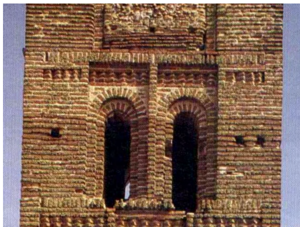
Fig. 28: detalle del penúltimo cuerpo de la torre de Rasueros. Una vez más encontramos la misma secuencia decorativa, sin embargo, aquí los arcos están resueltos mediante doble rosca de medio punto. Se aprecian restos de un revoco decorativo en las enjutas de los arcos.
